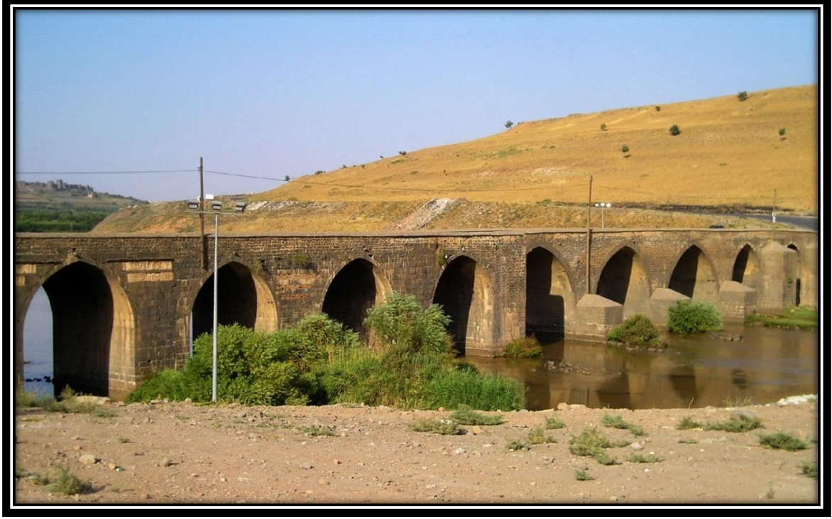
Şekil 6 : On Gözlu Köprü
