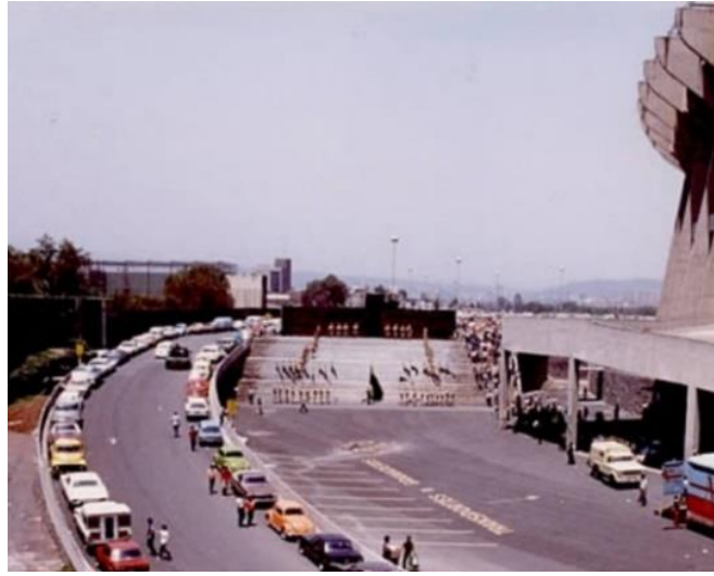
Şekil 9. Dune 1984 filminin Arrakis Yapısının merdivenleri için kullanılan gerçek yapı (Laurentiis, 1984)
