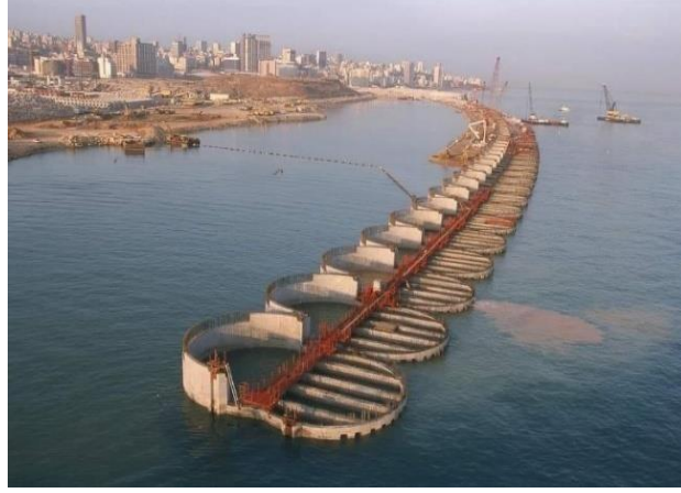
Şekil 1. Caisson in Qatar
